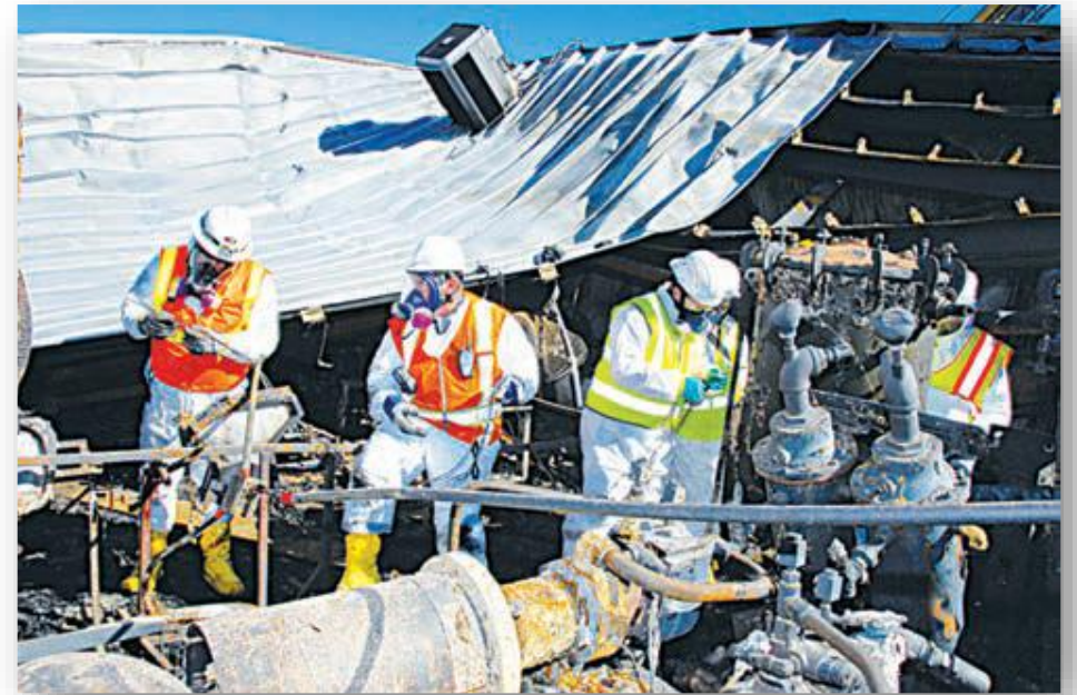
FIGURA 13.6.1 Los investigadores visten los EPP adecuados para las condiciones de trabajo existentes durante el análisis de este escenario.
